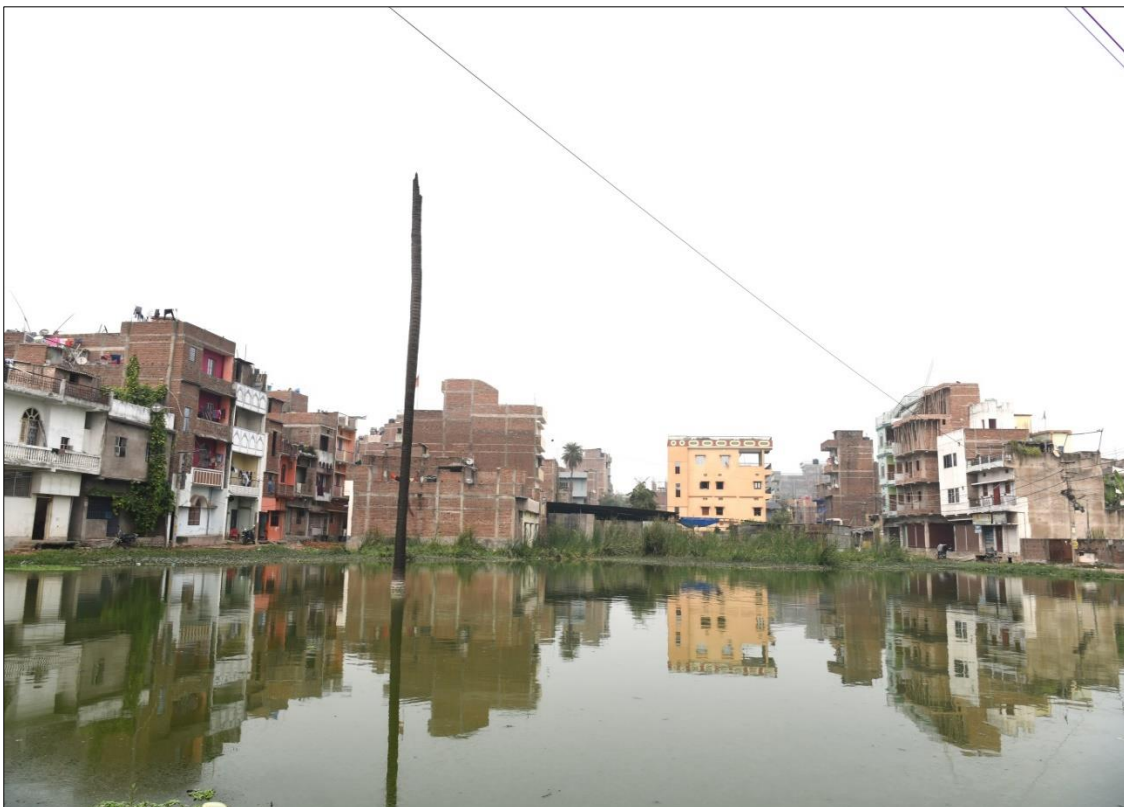
प्लेट 9: संस्मारक की विनियमित सीमा में आसपास का दृश्य – दक्षिण Plate 9: The view of the surroundings in the regulated boundary of the monument - South
