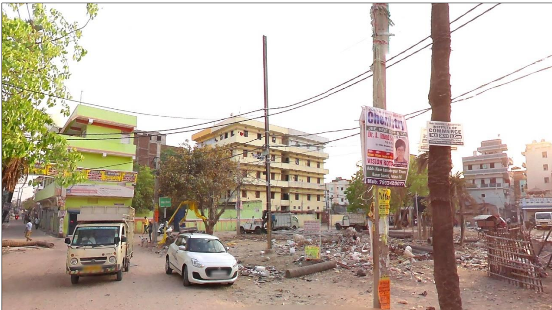
प्लेट 11: संस्मारक की विनियमित सीमा में आसपास का दृश्य – पश्चिम Plate 11: The view of the surroundings in the regulated boundary of the monument - West
